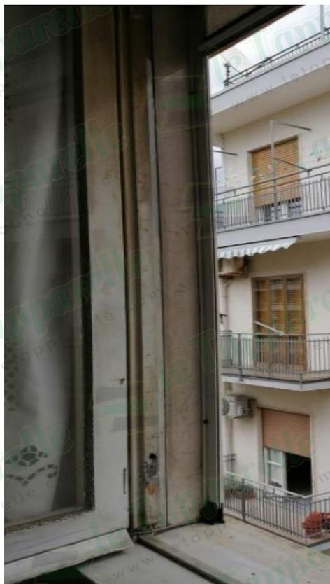
In questa installazione verranno adoperate guide **zincate** che saranno fissate al telaio di legno del vano luce tramite viti.
